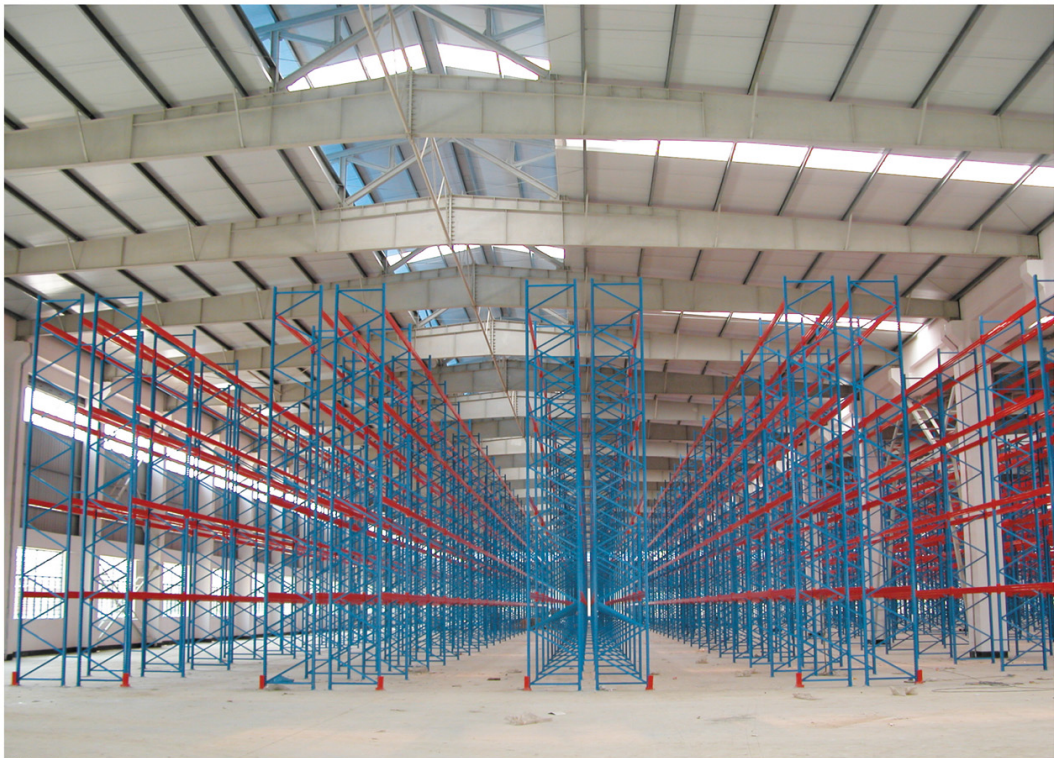
佛山照明高明仓由大昌公司承建。
