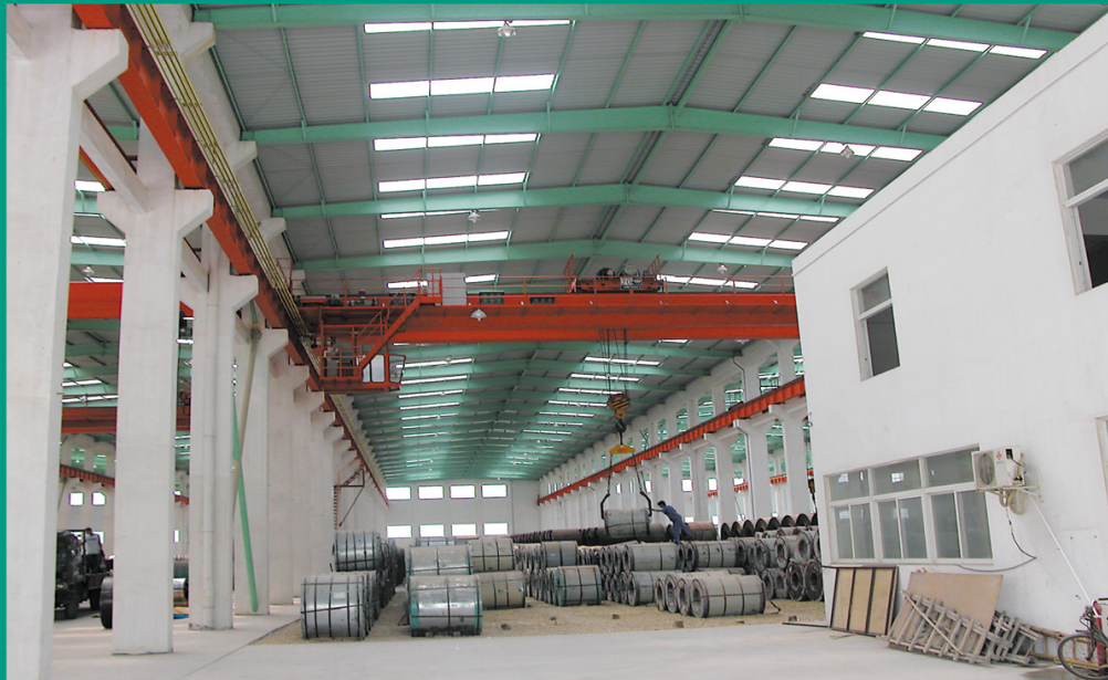
佛山乐从铁丰钢构工程由大昌钢构承建。
