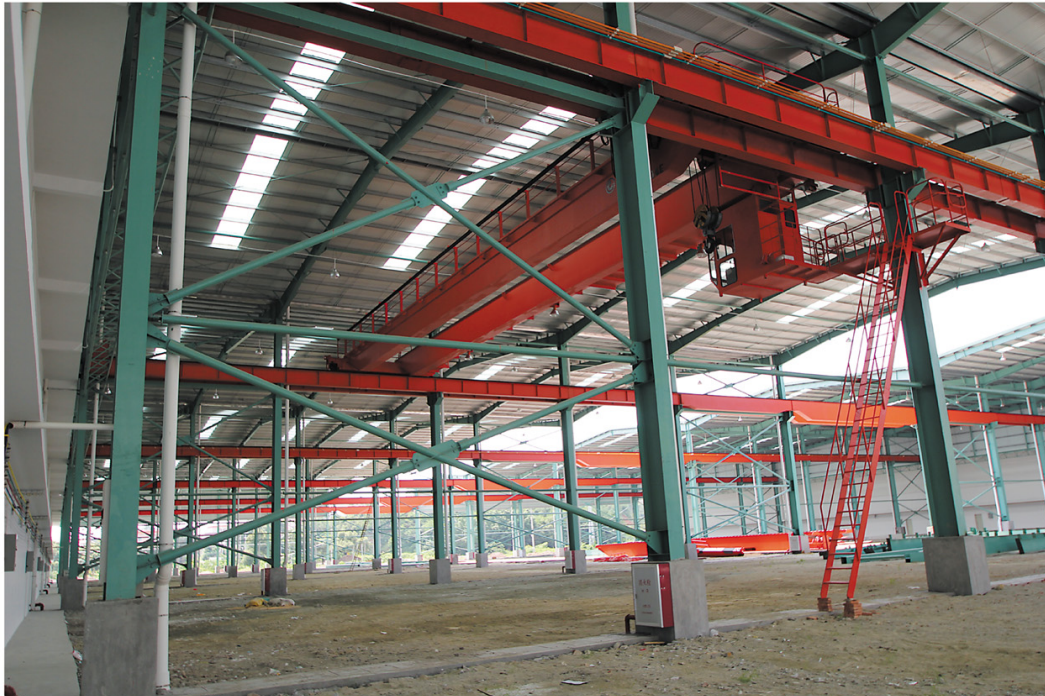
丹灶世海钢材物流中心钢构工程由大昌钢构承建。
